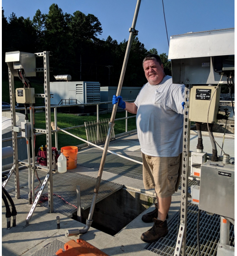
Shawn Maines, jefe operador de la planta de aguas residuales, realiza el mantenimiento mensual de una sonda de turbidez y sólidos en suspensión, una de las 12 sondas para diversas mediciones de la planta. Comenzó como operador I de la planta de aguas residuales de la ciudad en 1998 y obtuvo los títulos de operador II y III a lo largo de los años, con la designación de operador III que significa que ha obtenido el nivel más alto de certificación en el tratamiento de aguas residuales.
