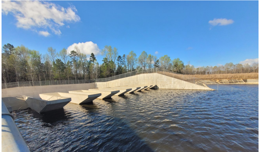
El nuevo aliviadero del embalse está diseñado con vertederos dentados, también llamados teclas de piano porque se parecen a las teclas de este instrumento .
