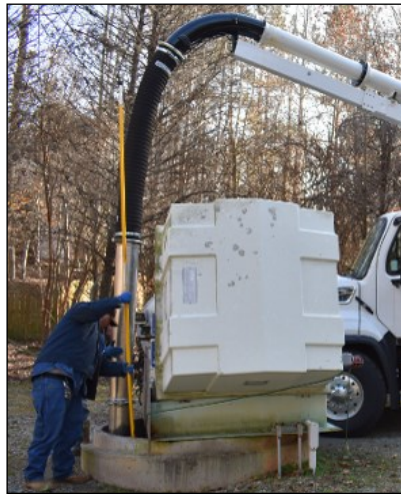
Un camión aspirador (arriba) limpia una estación de bombeo atascada. Los pozos de registro se elevan (derecha) en las llanuras de inundación, como a lo largo de Riverwalk
